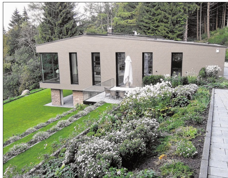
DIE KUNSTSCHAUENE fügt sich in die Schwarzwaldlandschaft ein. Die Außenhaut besteht aus Holzschindeln. Foto: Coenen
